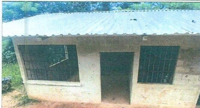
Foto 1: Cocina de Block, construcción de mesas de Concreto y equipación con polleton y pileta de concreto.
