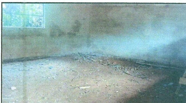
Foto 3: Aula pendiente de colocación de Piso
